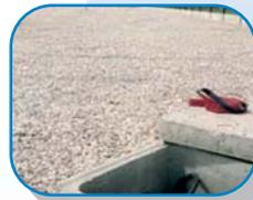
Sistema perimetral "no visible", enterrado. Se basa en la detección de la presencia de un intruso mediante la diferencia de presión que se genera en el terreno invadido, a través de la instalación enterrada de tubos hidráulicos presurizados sensibles a variaciones de presión pre-establecidos.
